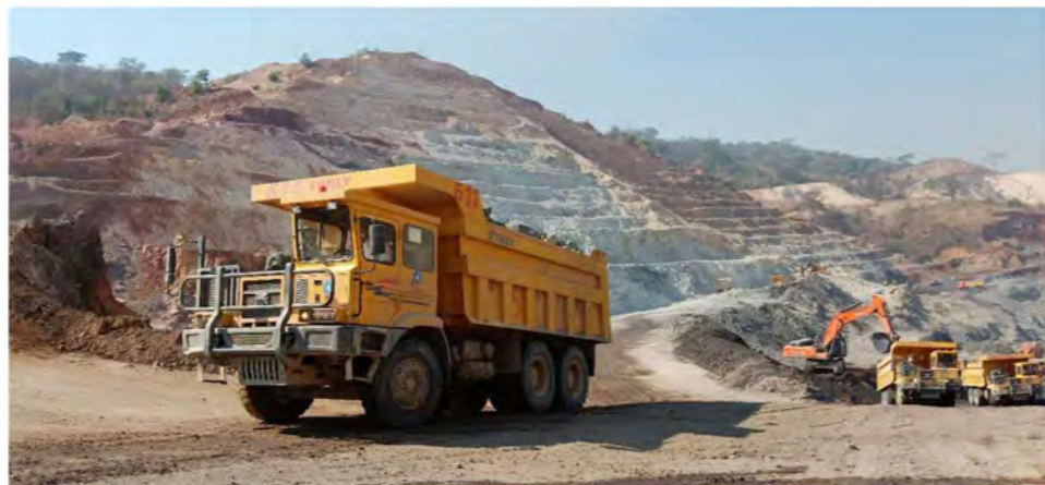
非洲矿区施工作业
